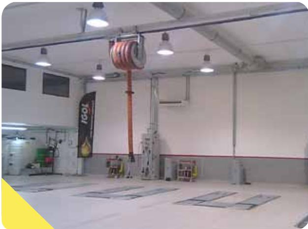
Installation avec bornes et enrouleur gaz d'échappement
