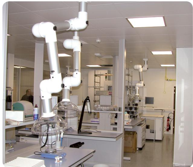
Ensemble de bras Ø 100 mm montage plafond, aspiration centralisée
