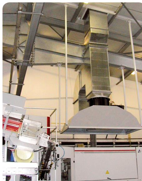
Machine à mouler les bouteilles plastiques, extraction
