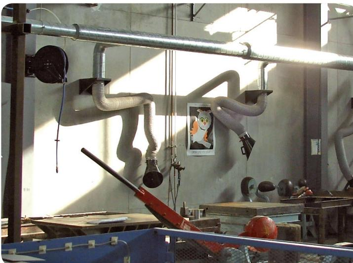
Aspiration de fumées de soudure centralisée/
