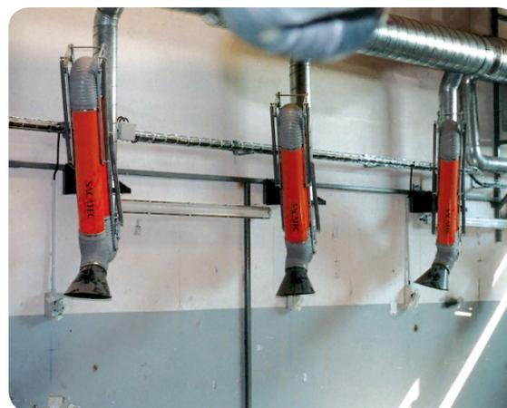
Série de bras métallique avec aspiration centralisée/Metallic arm for central system
