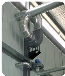
Fourni avec pièces aspiration et refoulement. Peinture Haute Densité pour réduire le bruit
