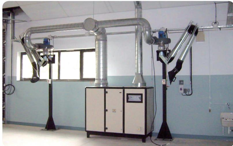
Bras autonomes avec filtration pour fumées soudure/Welding fume arms with fan
